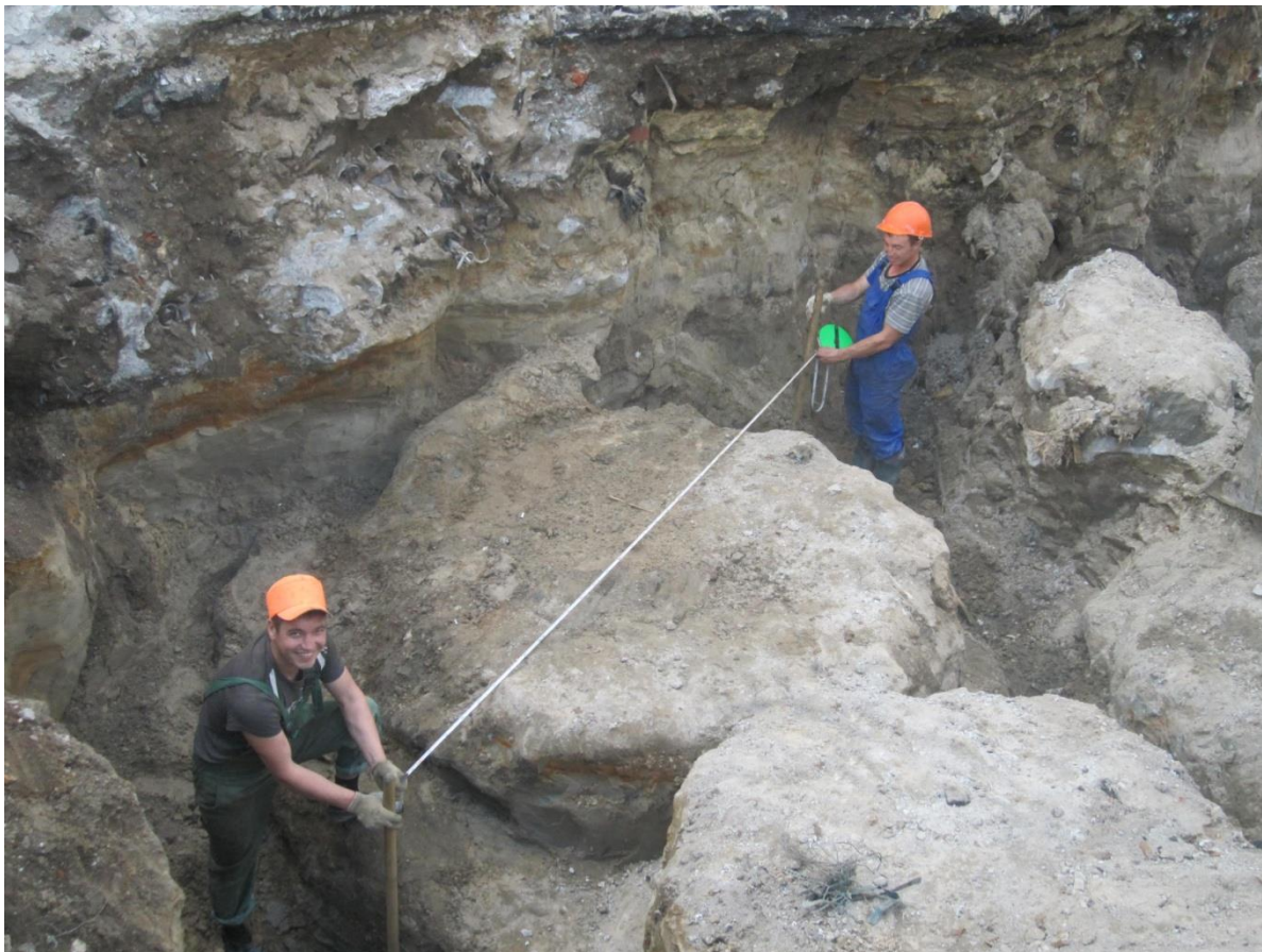
Рисунок 2 – Грунтоцементная колонна диаметром 3,5 м
