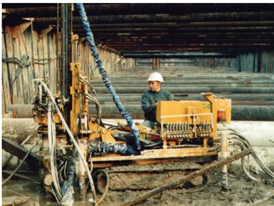
Фото 2. Устройство горизонтальной противофильтрационной завесы в днище котлована.
