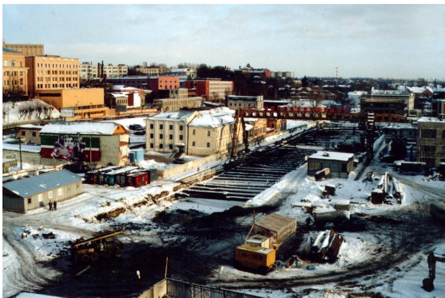
Фото 1. Котлован станции метро «Площадь Тукая» в г. Казани.
