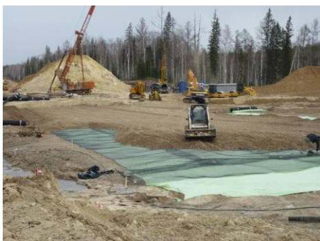
Рис. 7. Устройство гибкого ростверка
