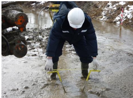
а) измерение диаметра грунтоцементной колонны; б) керны, выбуренные из тела Рис.6. а) измерение диаметра грунтоцементной колонны; б) керны, выбуренные из тела
