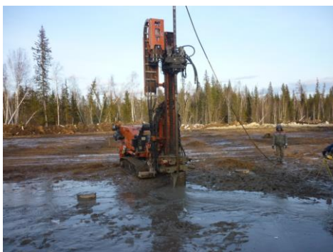
Рис. 5. Производство работ по технологии струйной цементации грунтов
