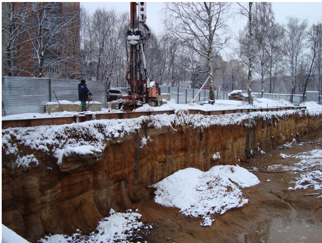
Рис. 6. Устройство свай-дублеров.
