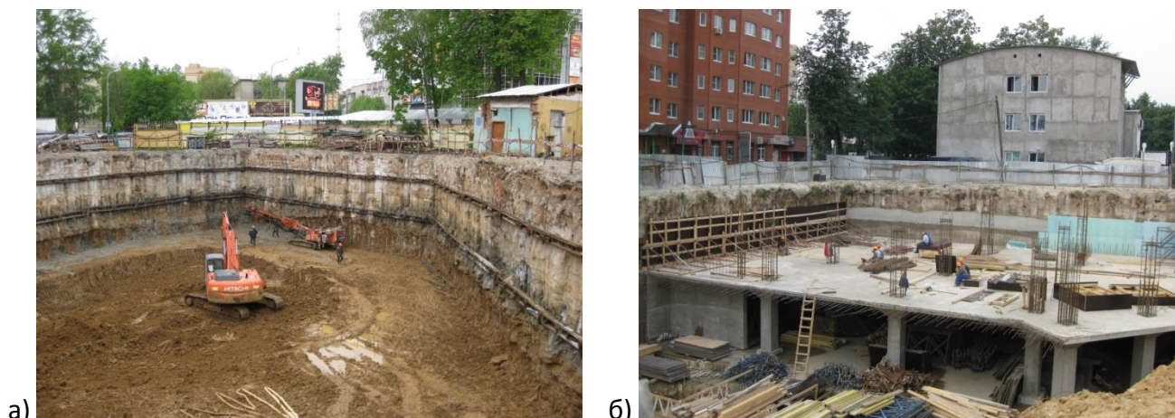
Рисунок 6. Устройство анкеров 3-го яруса (а) и откопанный котлован со зданием (б)
