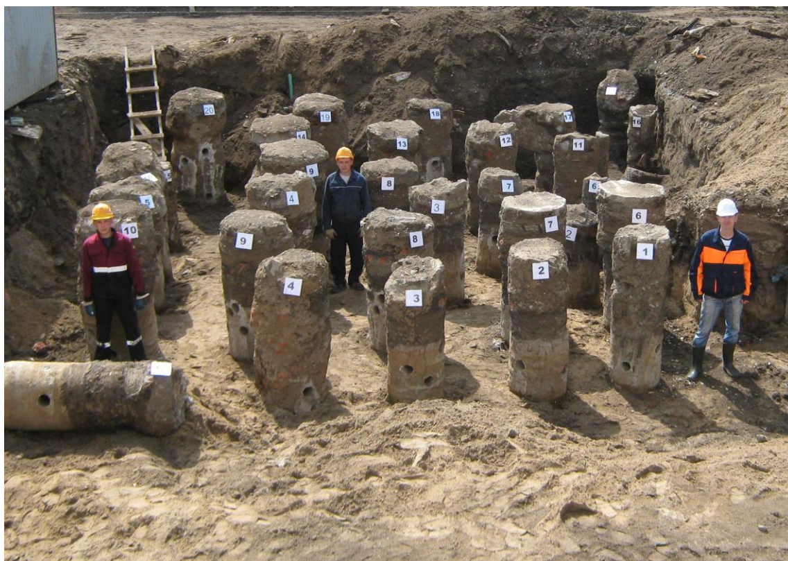
Рис. 5. Опытные грунтоцементные колонны
