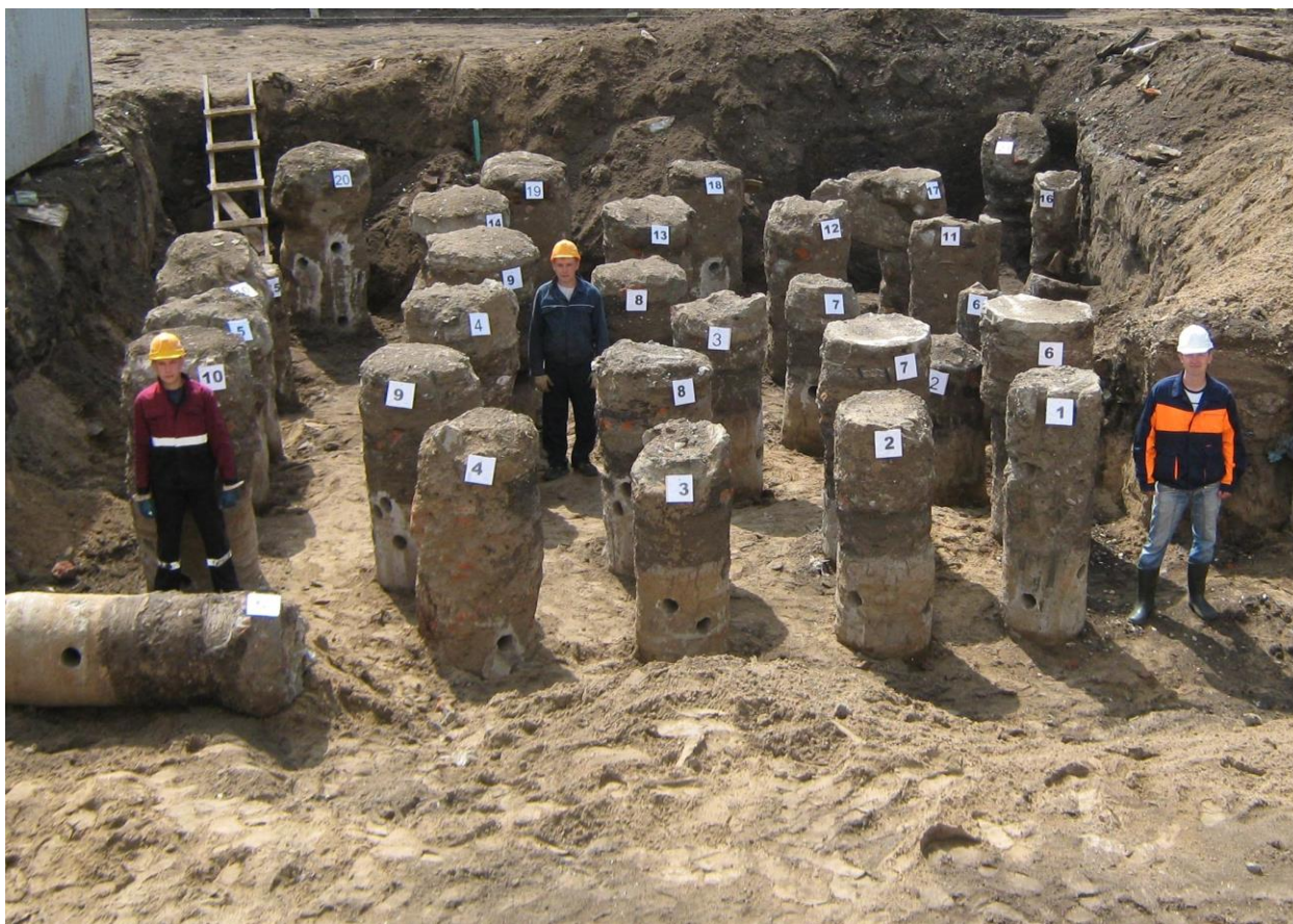
Рис. 6. Опытные грунтоцементные колонны.
