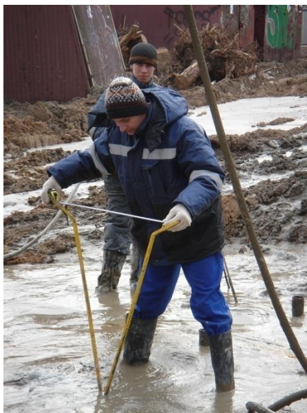
Рис.2 Измерение диаметра колонны с помощью прибора СПР-120.
